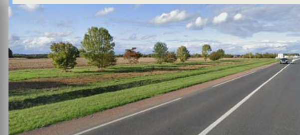
2- Entrée par le giratoire sur la RD910
