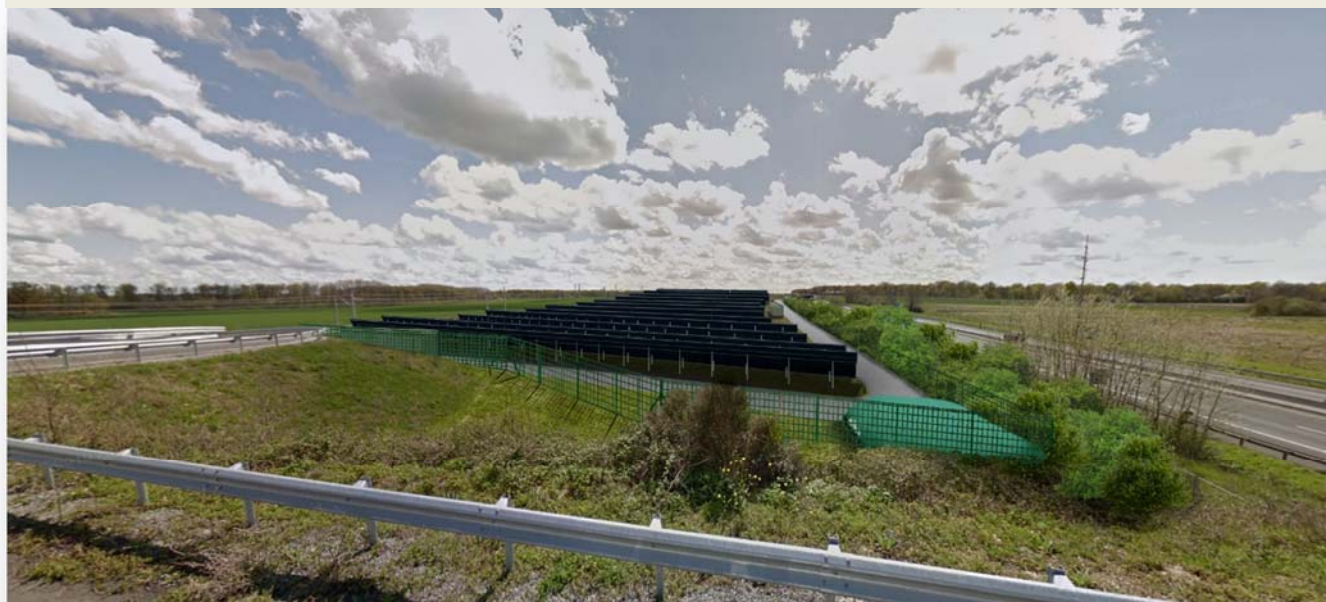
2- APRES INSTALLATION DU PARC PHOTOVOLTAIQUE / Vue depuis le pont de la route de Thilouze après la réalisation de la LVG
