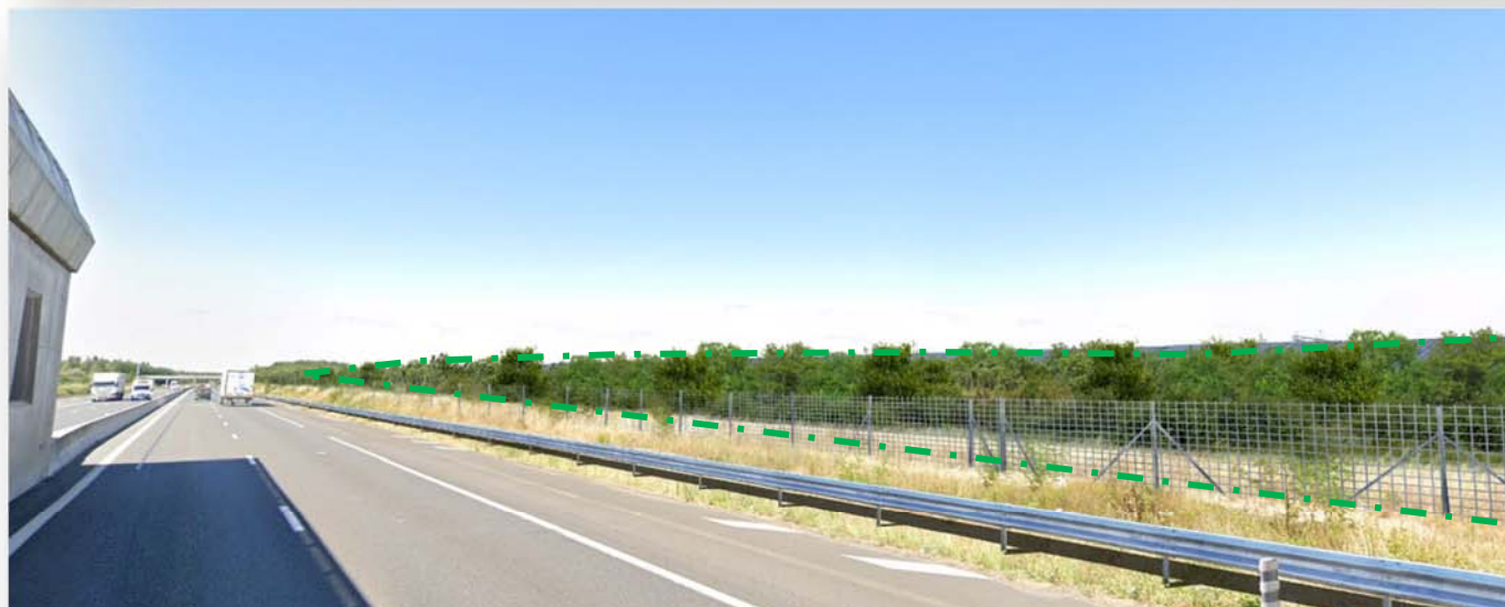
2- APRES INSTALLATION DU PARC PHOTOVOLTAIQUE / Vue depuis l'A10 sens sud /nord au droit du futur parc photovoltaïque
